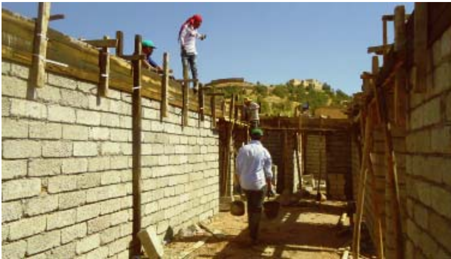
Der Rohbau des Kindergartens in Enishke (ICO-Hauptprojekt 2013) Anfang Juli 2013.
