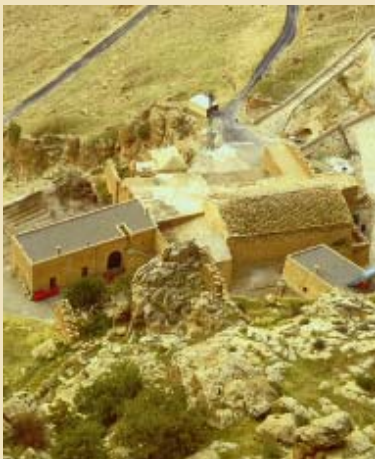
Das Satteldach der Hauptkirche des Augin-Klosters (rechts) ist schadhaft.
