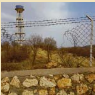
Beschädigter Zaun. Links hinten der Wasserturm von Badibe. Fotos (2): zVg
